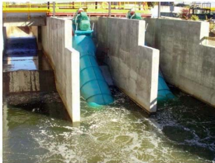
Turbinado Efluente EDAR SUR
